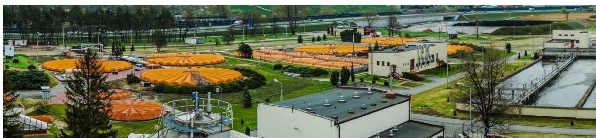
Fot. 1.2 Zakład „Pruszków” po modernizacji zakończonej w 2015 roku (źródło: Krzysztof Kobus Travelphoto.pl dla MPWiK w m.st. Warszawie S.A.)
