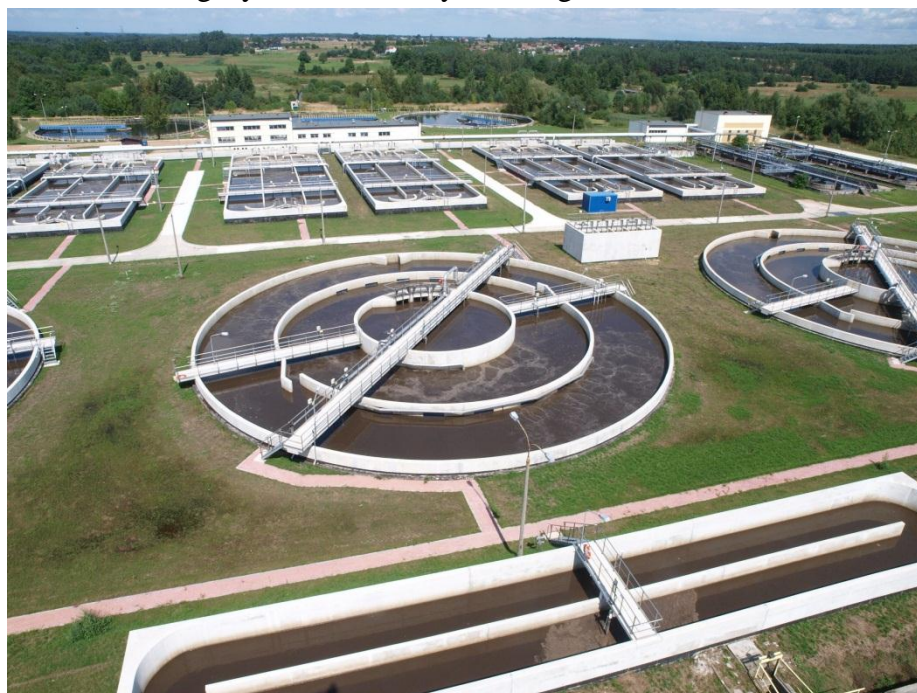
Fot. 1.3. Miejska oczyszczalnia ścieków w Radomiu (źródło: Wodociągi Miejskie w Radomiu Sp. z o.o.)
