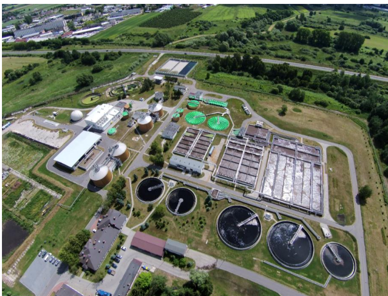
Fot. 1.1. Miejska Oczyszczalnia w Siedlcach po rozbudowie i modernizacji w 2014 roku (zdjęcie przekazane przez PWiK Sp. z o.o. w Siedlcach)
